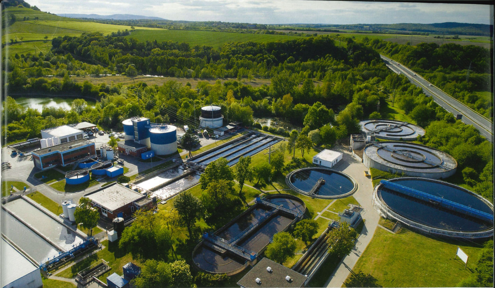
Bild 2 Klärwerk in Goslar – auf dieser Kläranlage wird die BioBrennstoffzelle aufgebaut werden
